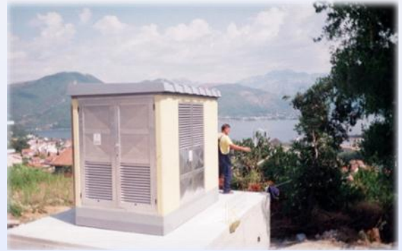
TS imaju primjenu i u uvjetima sa agresivnom atmosferom (vlaga, prašina, so magla).
