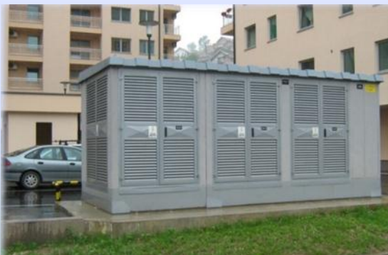
KBTS-3 TS sa vanjskim posluživanjem pogled na stranu trafo boxova NN ormara
