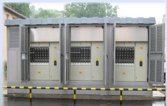
KBTS-3 TS sa vanjskim posluživanjem pogled na stranu trafo boxova NN ormara
